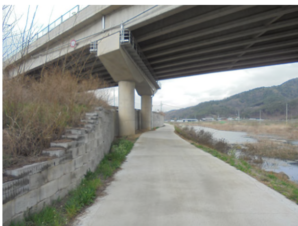
3공구 블럭식 옹벽 03
