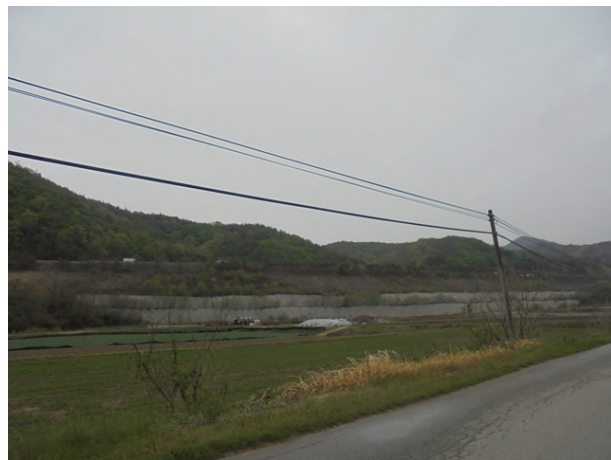
3공구 패널식 옹벽 02
