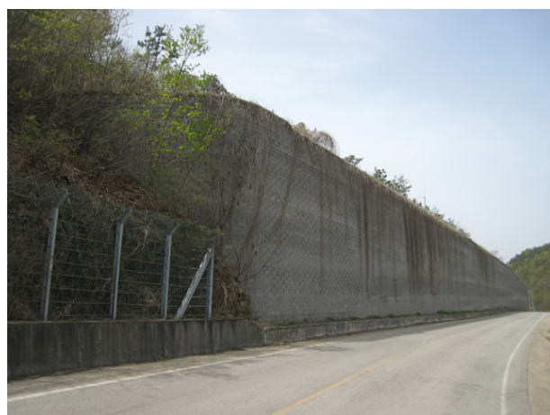
4공구 블럭식 옹벽 04
