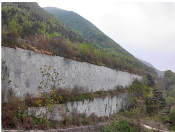
3공구 패널식 옹벽 01
