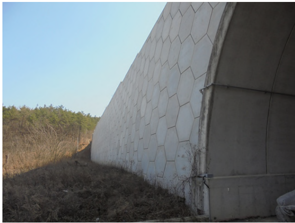
8공구 패널식 옹벽 13
