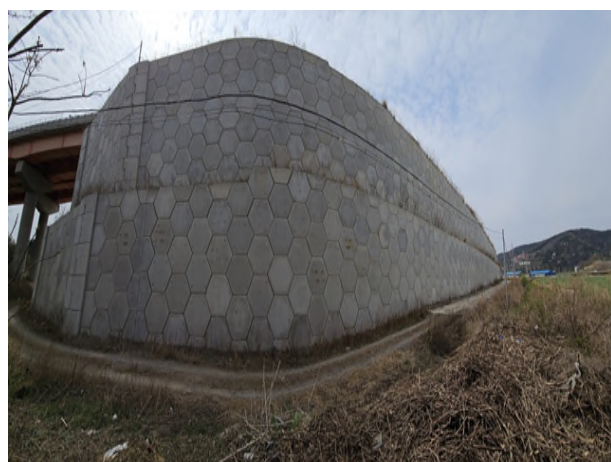
7공구 패널식 옹벽 12
