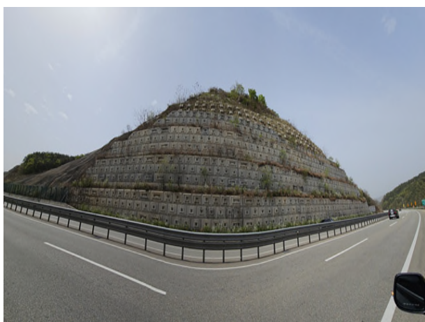
4공구 패널식 옹벽 05
