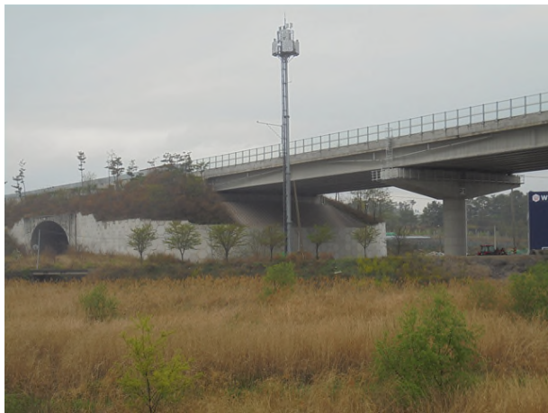
9공구 패널식 옹벽 15
