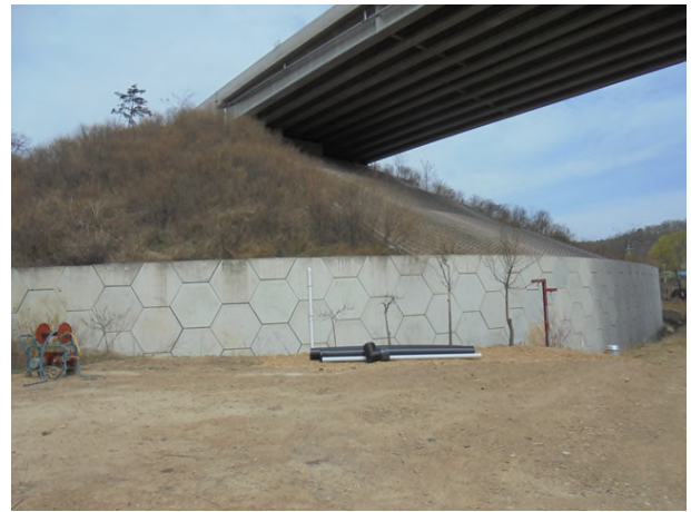
8공구 패널식 옹벽 14
