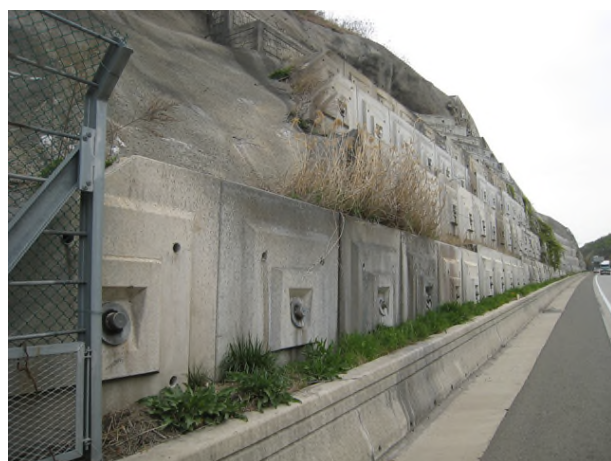
6공구 패널식 옹벽 10
