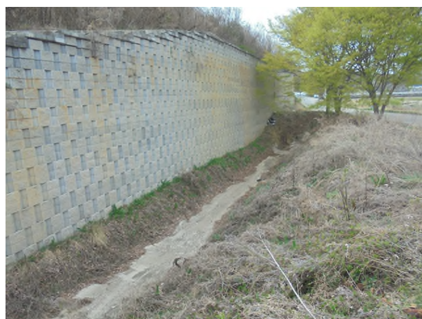
5공구 블럭식 옹벽 06
