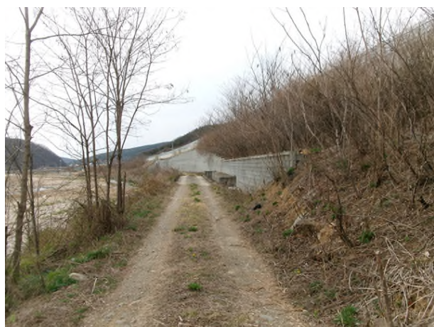
6공구 블럭식 옹벽9
